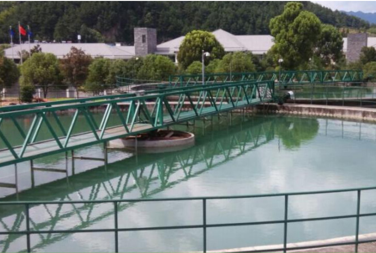
污水处理厂环境照片
