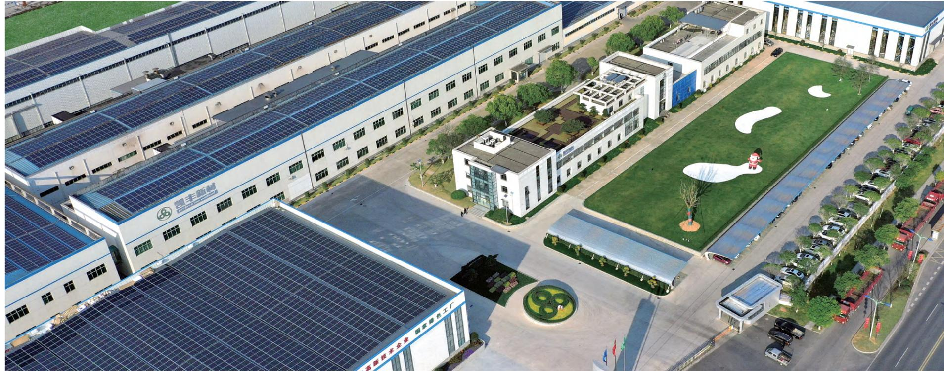
公司原有一期光伏5.5MW，2023年利用厂区空地新增4.5MW、利用楼顶新增1.25MW，目前总计光伏铺装量11.25MW。光伏发电量从2022年573万kwh增加至2023年954万kwh，全年增加了66%；整体可再生能源电量使用比例增加10%。按照全国电网平均排放因子0.5703tCO<sub>2</sub>/MWh计算，相当于全年新增减少2173吨碳排放。
